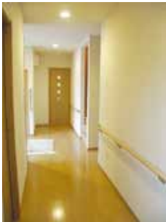
◀ 廊下の幅は広く取り、手摺を設置。戸は全て引き戸とし、将来の事まで考えられた設計です。
